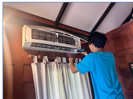
ภาพถ่ายที่ 2.2-20 การทำความสะอาดเครื่องปรับอากาศ
