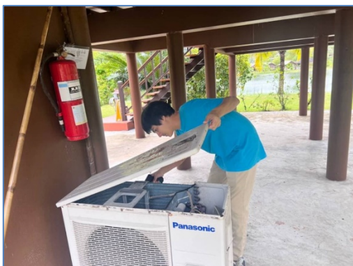
ภาพถ่ายที่ 2.2-20 การทำความสะอาดเครื่องปรับอากาศ
